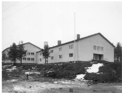
Ulkoarkkitehtuuri Kytkeyty löyten barjakkatoteutet rakennuskappaleet
